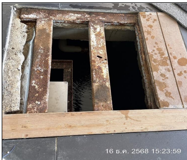
รูปที่ 2.4.1.1-1 ถังเก็บน้ำใต้ดิน
