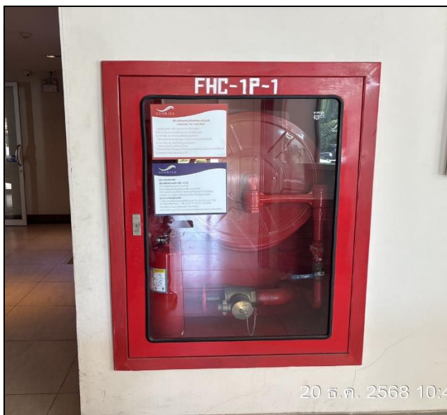
รูปที่ 2.4.7.3-1 ตู้เก็บสายน้ำดับเพลิงพร้อมอุปกรณ์
